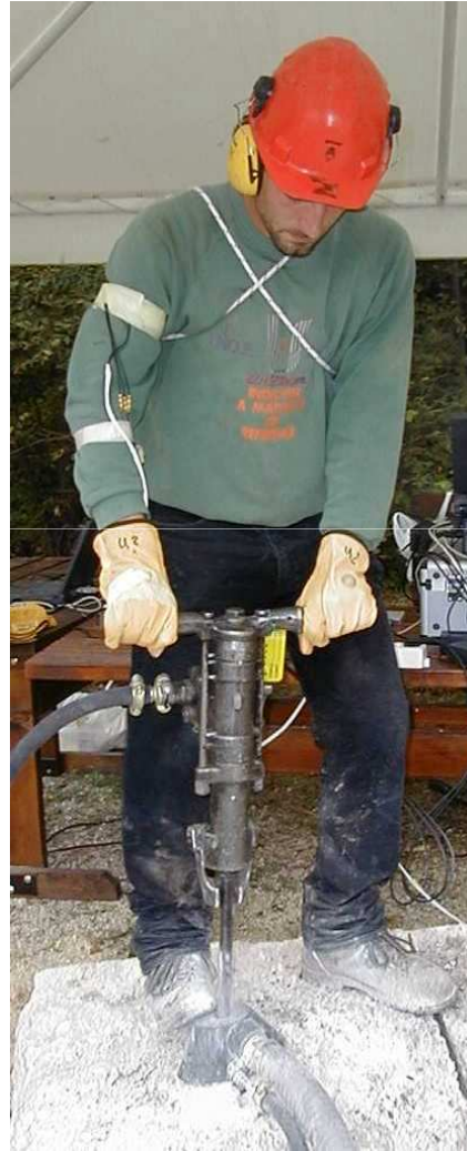
Martelli pneumatici: perforazione
