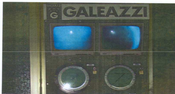
Figura 10 – Monitor video inseriti nel quadro di controllo della camera iperbarica verde, collegati a due video camere posizionate all'esterno in corrispondenza degli oblò della sezione di trattamento e di quella di trasferimento.
