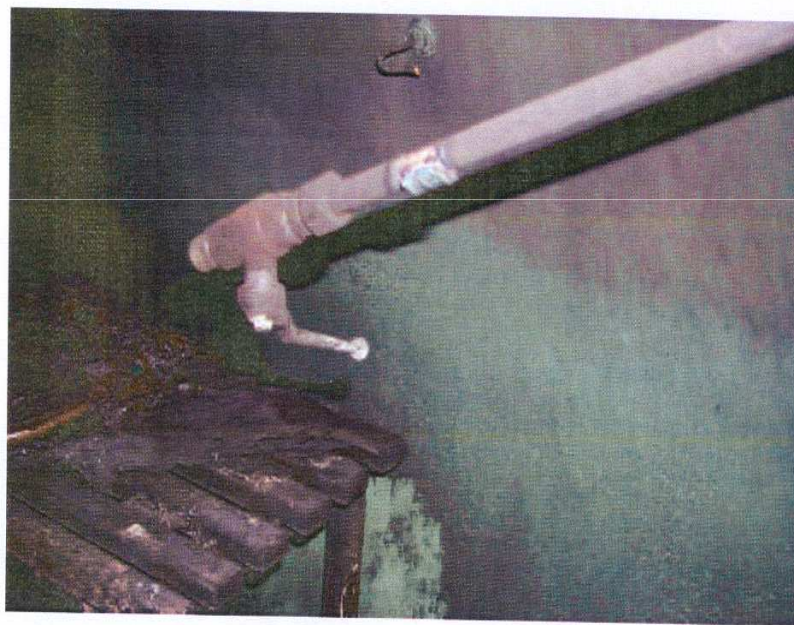
Figura 14 – particolare del tubo e della saracinesca di attivazione della doccia, che però è evidentemente assente. La saracinesca, realizzata mediante una valvola a sfera da 1/2", è nella posizione di chiusura.
